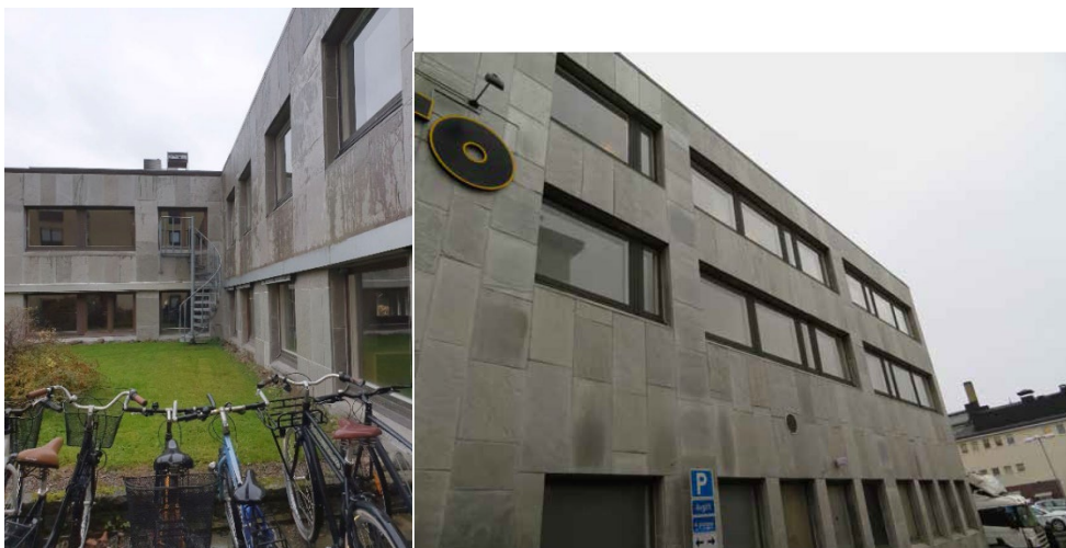
Bilder. Till vänster Doppingen 15 lågdal från innergården (Linköpings kommun) och till höger från Drottninggatan (WSP 2017).
