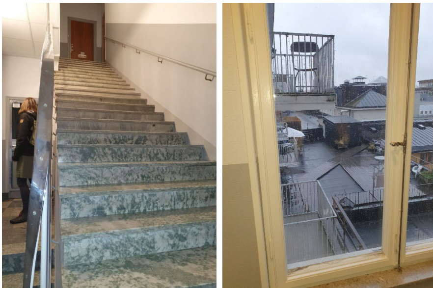
Bilder. Interiörbilder från trapphus inom S:t Larsgatan 29, med marmorplattor i golv och trappa, formgivet trappräcke i smide samt glasade partier med tidstypiska detaljer (Linköpings kommun).
