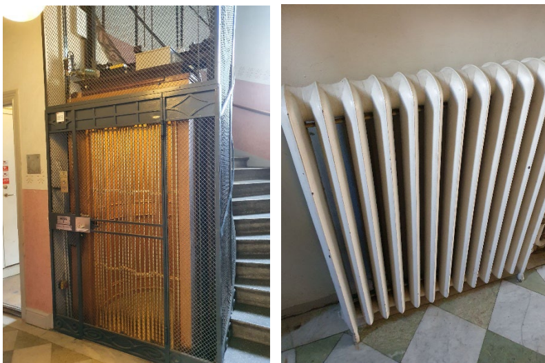
Bilder. Interiöra bilder från gatuhuset inom Doppingen 2, som visar hisskorg i trappspindel och dörr till hiss (WSP 2017).
