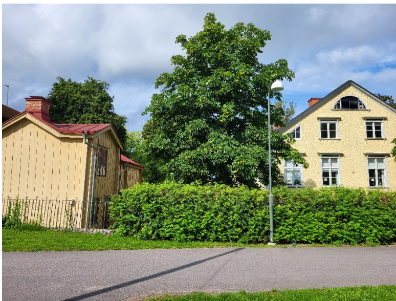
Bild: Foto på befintlig bebyggelse på Akilles 4, till vänster gårdshuset och till höger domprostgården.
