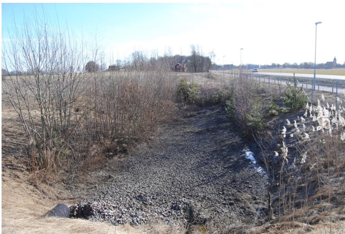
Bilden ovan visar befintlig dagvattendamm på planområdet.
