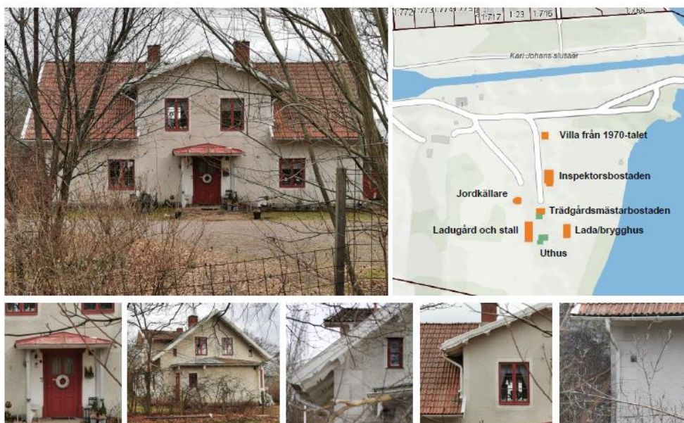
Bild. Slussinspektorsbostaden. Orange markering på kartbilden, byggnad som bedöms särskilt värdefull (PBL 8:13), grön markering, byggnad bedöms värdefull
