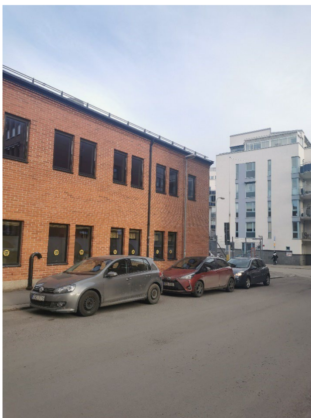
Byggnad inom planområdets södra del sett från Hertig Karlsgratan mot Engelbrektsgratan.
