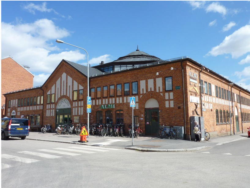
Cirkusbyggnaden, vy från Platensgatan.
