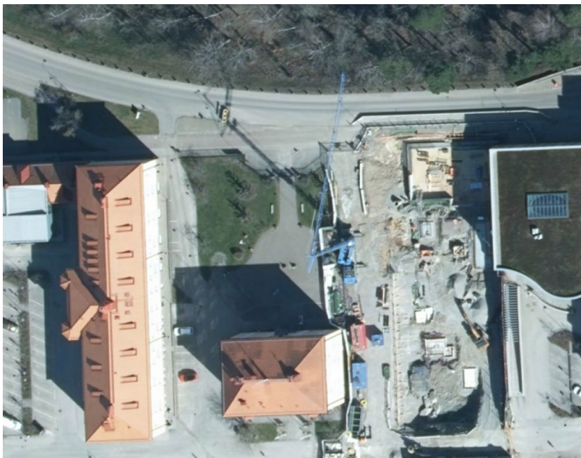
Ortofoto som visar västra kansligården, befintlig situation (2023). Till höger i bilden syns byggarbetsplatsen för den nya byggnaden som uppförs för att inrymma vårdverksamhet för Region Östergötland - Ögonklinken. (Lantmäteriet)
