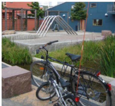
Dagvattenhantering i kombination med växtlighet. Detta kan vara ett lämpligt sätt att fördröja avrinningen till det allmänna ledningsnätet och samtidigt få ett tilltalande gröninslag i stadsmiljön.
