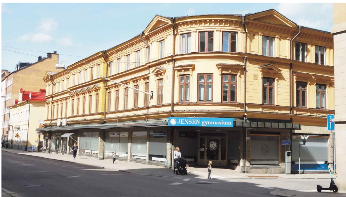
Foto som visar huvudbyggnaden, det tidigare Grand Hotel, med vy från S:t Larsgatan. (Fredriksson arkitektkontor AB)
