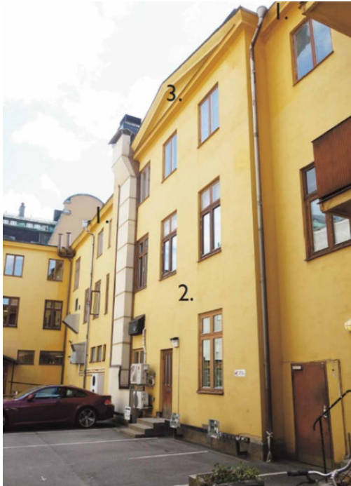
Foto som visar huvudbyggnaden från gårdssidan. (Fredriksson arkitektkontor ab)
