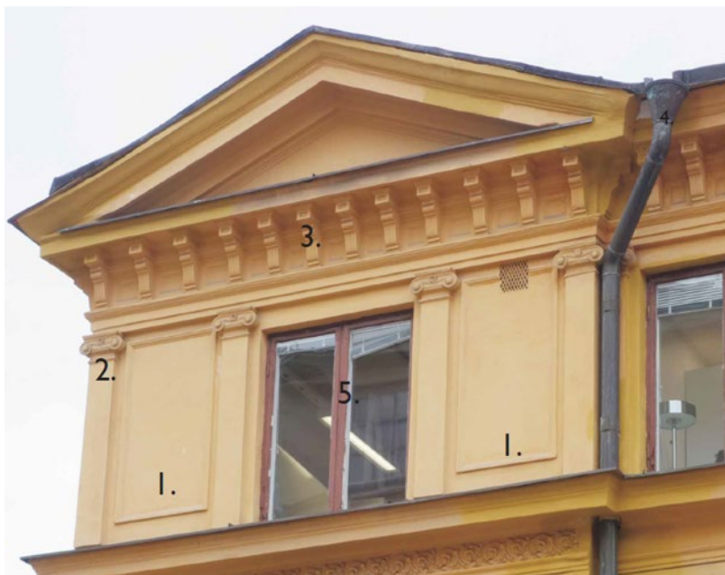
Foto som visar den övre delen av huvudbyggnaden. (Fredriksson arkitektkontor ab)
