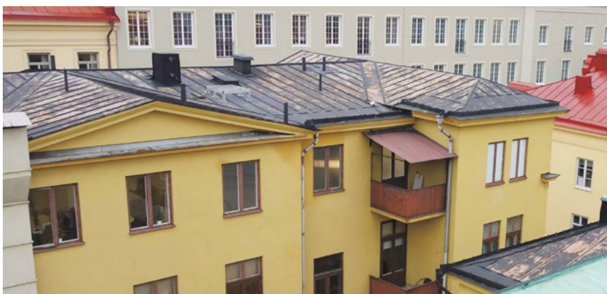
Foto som visar huvudbyggnadens tak. (Fredriksson arkitektkontor ab)
