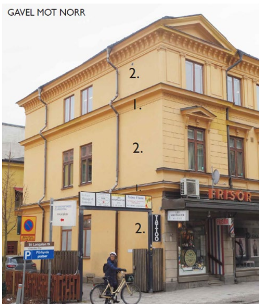
Foto som visar huvudbyggnaden från S:t Larsgatan. (Fredriksson arkitektkontor ab)
