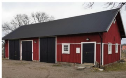
Bild. Ladugård som flyttas.
