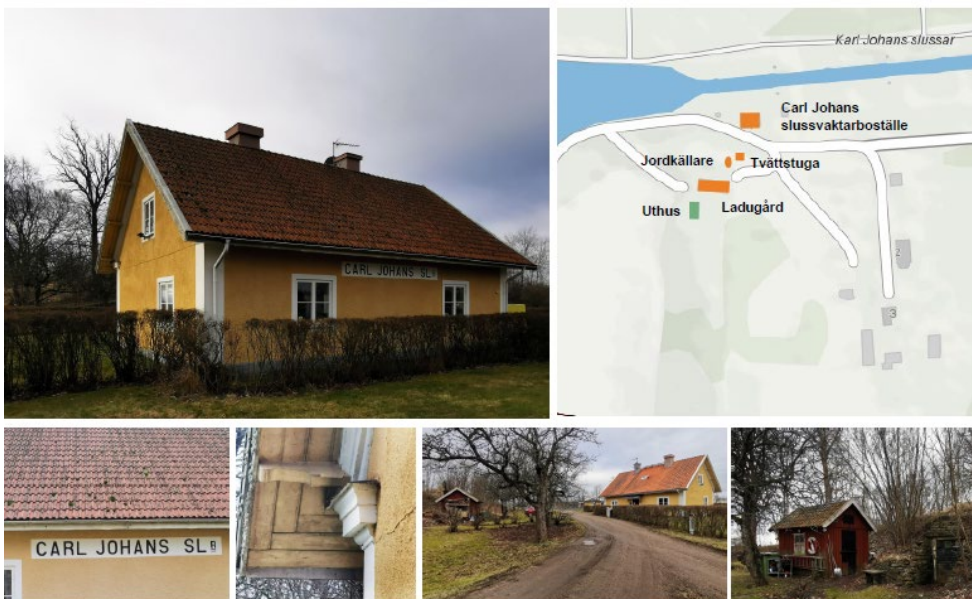
Bild. Carl-Johans slussvaktarboställe, bostadshus (gul byggnad). Orange markering på kartbilden, byggnad som bedöms särskilt värdefull (PBL 8:13), grön markering, byggnad bedöms värdefull (PBL 8:17). (Bilder från kulturmiljöutredningen, Arkeologerna, rapport 2021:1)
