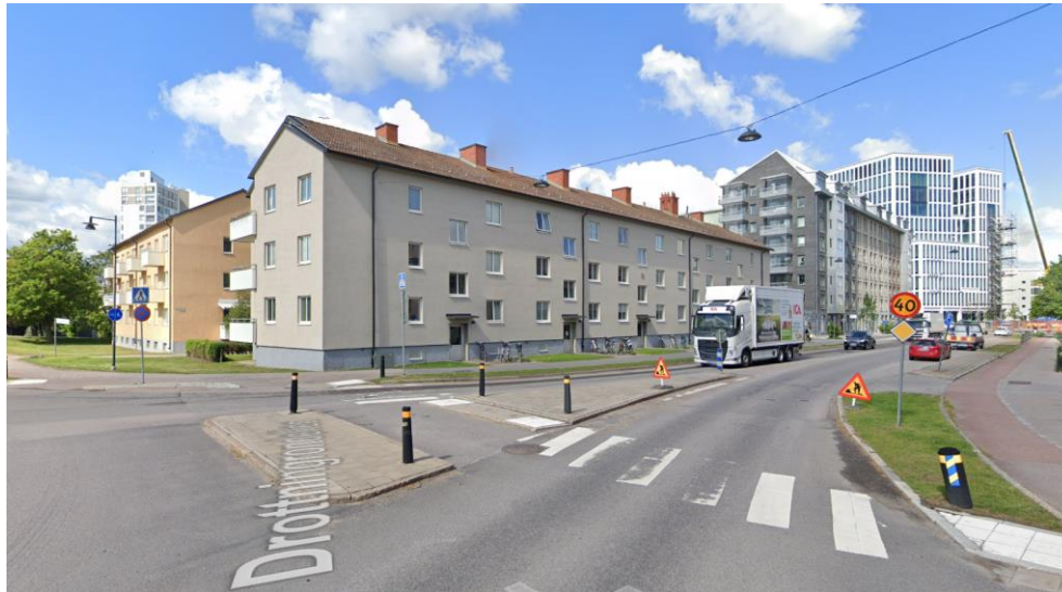
Bild. Befintlig bebyggelse inom kvarteret Krigaren från Drottningrondellen. Källa: Google Street view, 2022.
