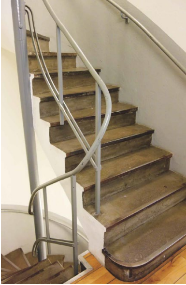
Foto som visar trapphus i gårdsbyggnaden. (Fredriksson arkitektkontor ab)
