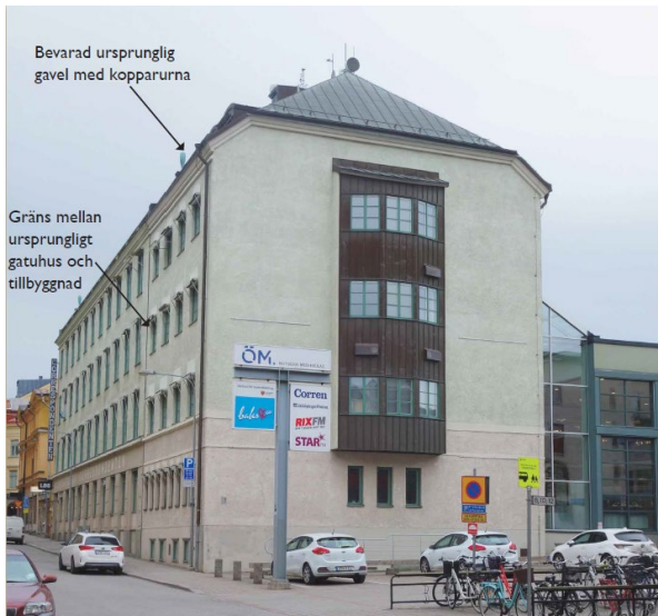
Foto som visar gatuhusets östra gavel vid tillbyggnad. (Fredriksson arkitektkontor ab)
