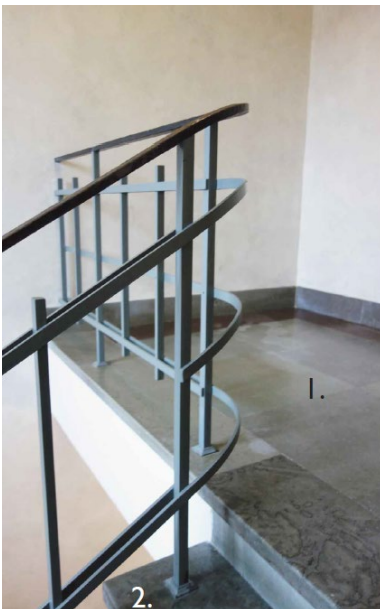
Foton som trapphus i gatuhuset. (Fredriksson arkitektkontor ab)
