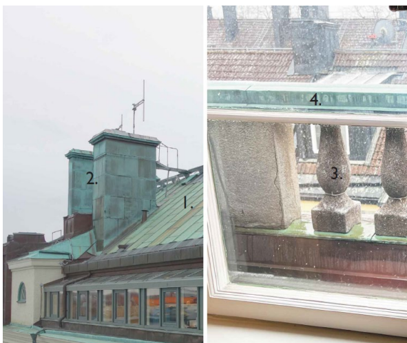
Fotot till vänster visar en del av taket på gatuhuset och fotot till höger visar del av balustrad (Fredriksson arkitektkontor ab)
