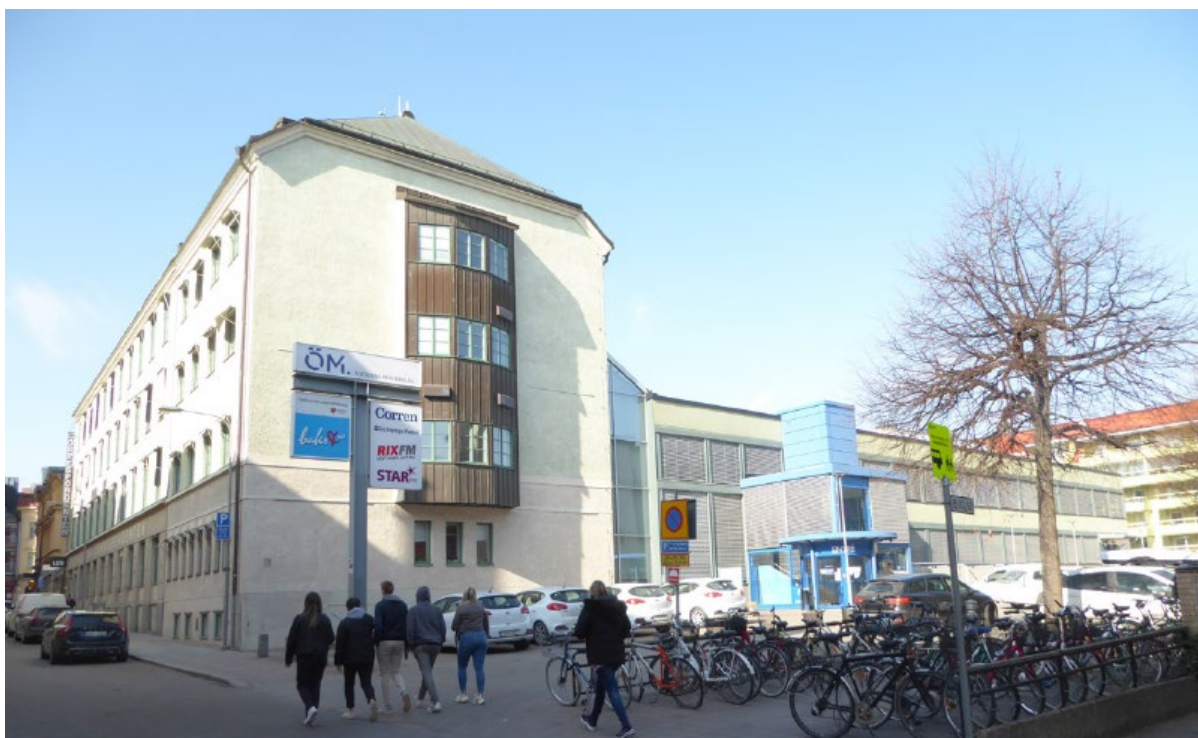
Foto som visar befintlig bebyggelse inom Badhuset 14 med vy från Badhusgatan mot huvudentrén. (Sonark arkitektkontor AB)
