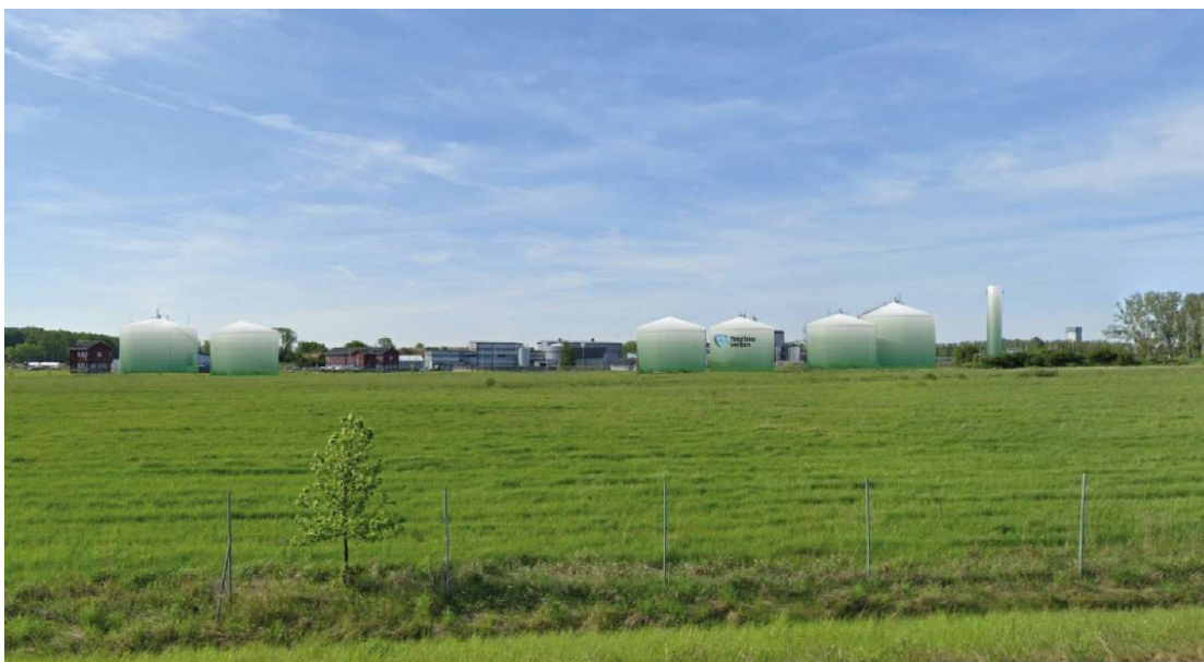
Figur 6. Visar anläggningen före efter färgsättning och tillskott av byggnader. WSP
