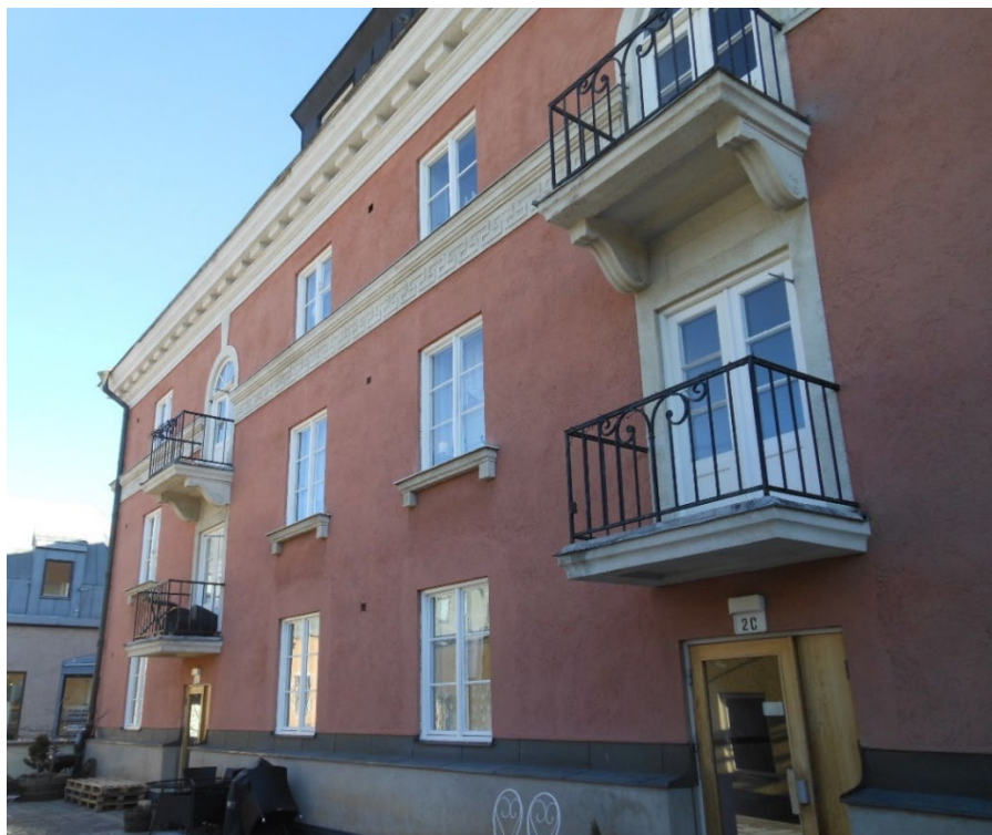
Del av Delfinpalatsets fasad mot innergården.
