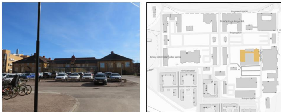
Bilden och kartan visar Gymnastik- och ekonomibygnad (nr7). (Bild och karta WSP, Kulturmiljöutredning 2021-06-16, Smedstad 1:21 m.fl. Garnisonen. Den ursprungliga kartbilden har justerats för att stämma med de korrekta gränserna för de ursprungliga byggnadsdelarna)
