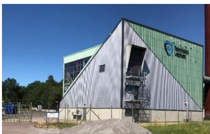
Tekniska verkens hetvattencentral
