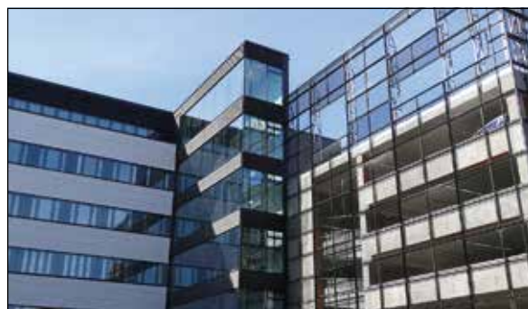
Parkeringsanläggning vid Universitetssjukhuset.
