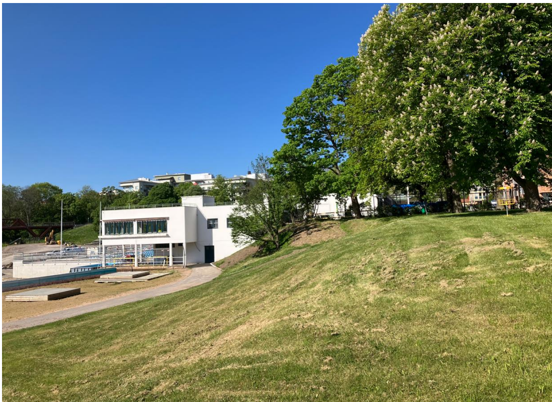
Aktuell yta där byggnation och åtgärder ska ske 2025 - 2026
