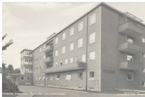
Figur 56 - Den tidigare öron-, näs- och halskliniken som byggdes 1949-1951. Bild från Linköping US, innerstaden 1:30, norr 1 och 2 samt väst 2, Fredrikssons arkitektkontor ab, 2018-05-04
