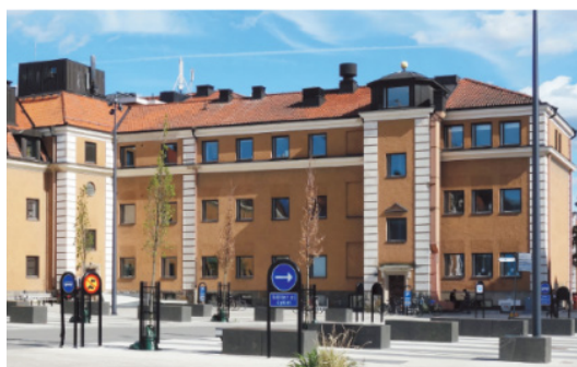
Figur 54 - Före detta kirurgiska kliniken som är sammanbyggd länslasarettet. Fredrikssons Arkitektkontor, 2018-04-05
