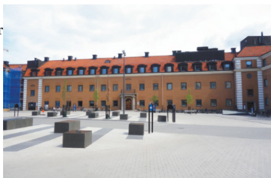
Figur 53 - Sammanbyggnad med före detta kirurgiska kliniken till länslasarettet. Fredrikssons Arkitektkontor, 2018-04-05
