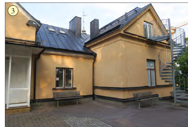
4: Plåttaket med parallella hakfalsar.
