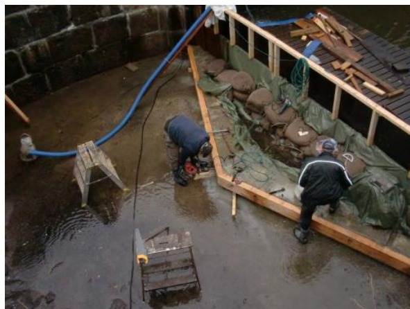
Tröskel under konstruktion i Nykvarns sluss
