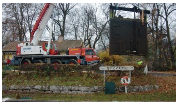
Lyft av port i Nykvarns sluss.
