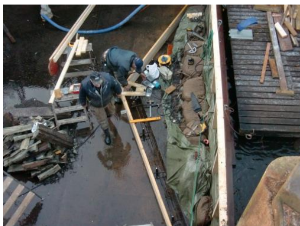
Tröskel under konstruktion i Nykvarns sluss
