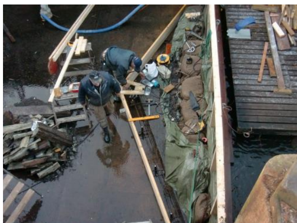
Tröskel under konstruktion i Nykvarns sluss
