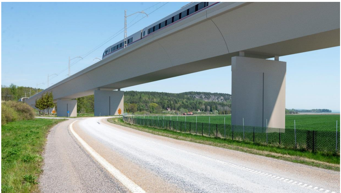
Figur 4. Vy söder om tunnelpåslaget (Bild 1).
