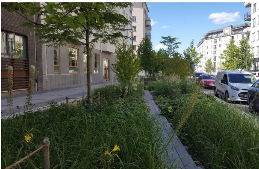
Bild 30. Exempel på regnbädd i gaturum som renar och fördröjer dagvatten (Sweco, 2022).
