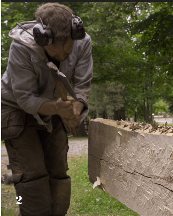
1. Under året genomfördes underhållsarbete på museigårdarna, här lagar museets snickare Daniel Modig ett sticketak. 2. På Krogsfallsgården ersattes delar storstugans stockar som blivit utsatta för väta. Allt arbete på museigårdarna görs med gamla tekniker och noggrann hantverkskunnighet. 3. Årets Fersen Week hölls på Ljungsslott och bjöd bland annat på catwalk med mode från 1770-1820 i historisk miljö.
