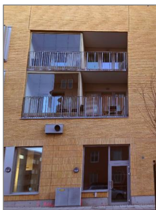
Till vänster: Utanpåliggande balkonger som glasas in ger ofta ett klumpigt intryck som också stjälar ljus från bostadslägenheten. Mitt och till höger: Exempel på andra lösningar är att anordna fransk balkong/loggia som en integrerad del av byggnaden. Exempel från Linköping.
