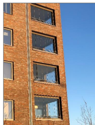
Till vänster: Utanpåliggande balkonger som glasas in ger ofta ett klumpigt intryck som också stjälar ljus från bostadslägenheten. Mitt och till höger: Exempel på andra lösningar är att anordna fransk balkong/loggia som en integrerad del av byggnaden. Exempel från Linköping.
