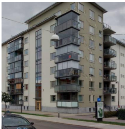
Till vänster: Utanpåliggande balkonger som glasas in ger ofta ett klumpigt intryck som också stjälar ljus från bostadslägenheten. Mitt och till höger: Exempel på andra lösningar är att anordna fransk balkong/loggia som en integrerad del av byggnaden. Exempel från Linköping.
