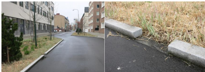
Exempel på regnbäddar som kan anläggas i en funktionszon. Bild på Monbijougatan i Malmö. Foto: Tyréns 2017.
