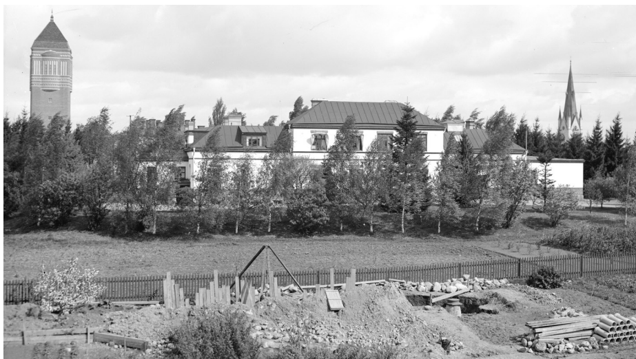
Nr 10. Den 2 juni 1908 kunde domprost John Personne inviga Westmanska BB i Linköping. Staden hade nu fått ett tidsenligt barnbördshus. Anläggningen kunde realiseras med hjälp av donerade medel från Henric Westman, stadens stora välgörare. För byggnadens ritningar stod Janne Lundin.
