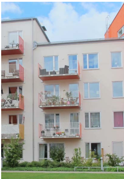
Exempel på hur en ljus fasad mot gården kan bidra till en ljusare gårdsmiljö. Annedal i Stockholm.
