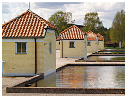
Råberga vattenverk. Foto: Hejdlösa bilder.
