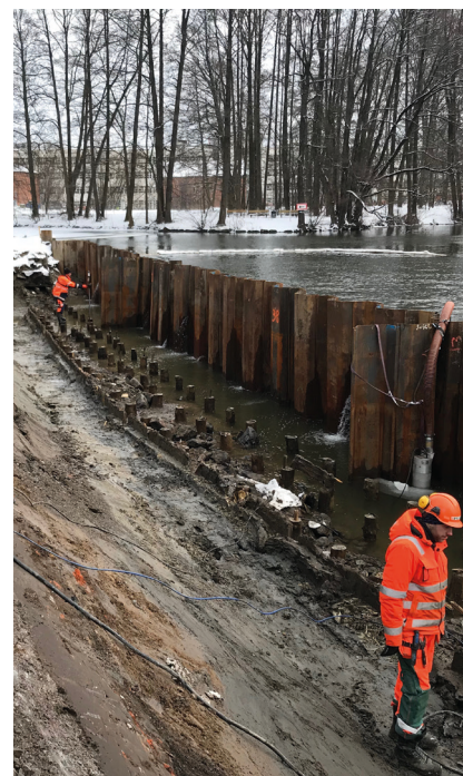
Kajkanten längs Stångån Kinda kanal renoveras och rustas upp för att kunna stå stabilt många år framöver.
