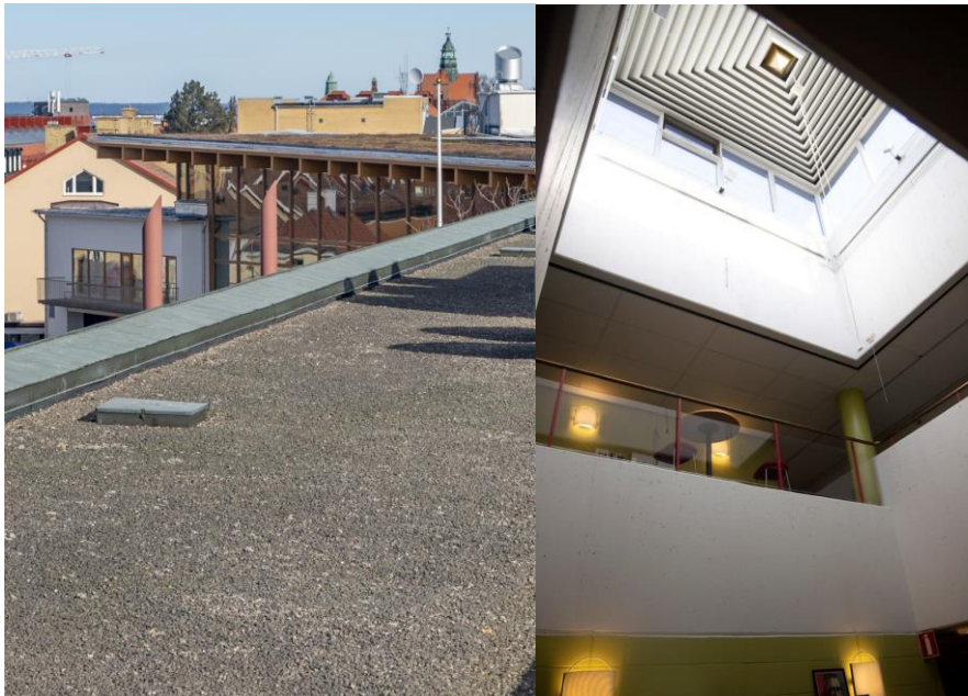
Bild. Till vänster. Landsstatshusets platta tak med kopparsarg. Till höger. Ett av ljusschakten med taklanternin. I bilden syns även den konstnärligt uppförda ljudabsorbenten samt de ursprungliga räcken som finns i ljusschakten.
